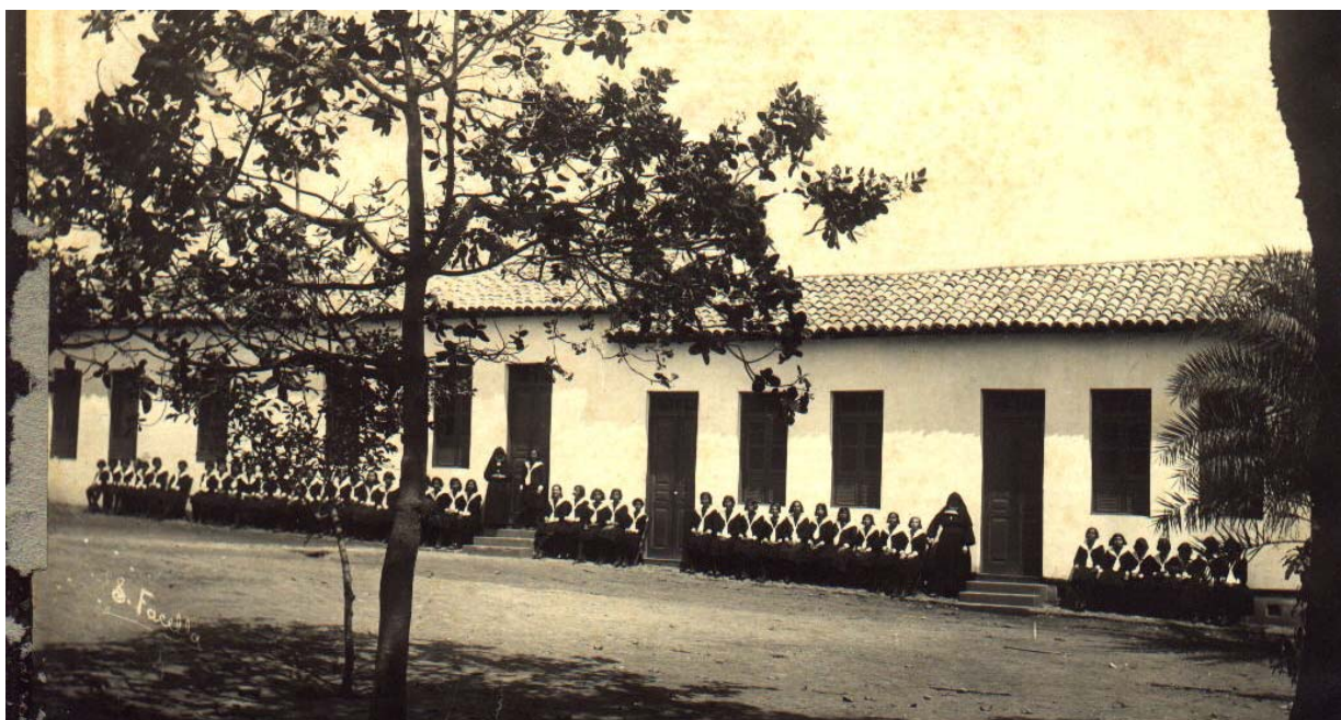
FOTO 3: Antiga edificação do CIC – Dormitório lateral do pátio interno FONTE: Arquivo fotográfico do CIC – Registro de 1938
