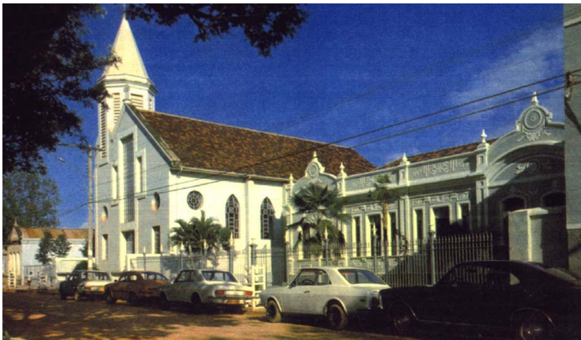
FOTO 11: Fachada das Antigas Edificações do CIC e da Capela, na Av. Cel. Prates FONTE: Arquivo fotográfico do CIC.
