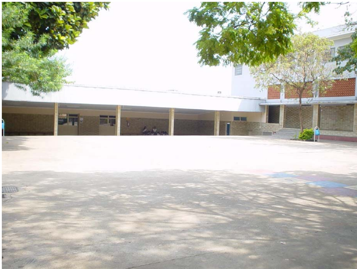
FOTO 23: Vista parcial do pátio, pouco antes do recreio. No fundo espaço coberto para atividades extra-sala FONTE: Registro de campo
