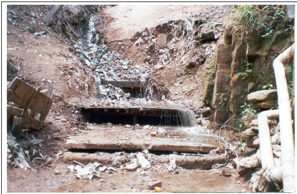
FIGURA 5: Acúmulo de lixo e esgoto a céu aberto Fonte: Santos (2004)
