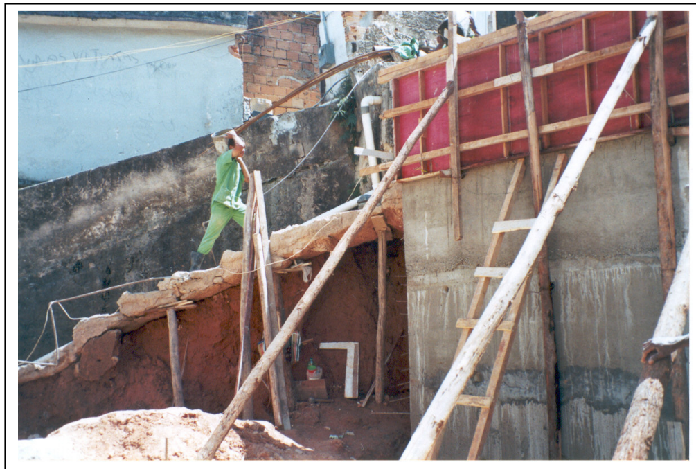
FIGURA 6: Funcionário da Urbel fazendo obras de contenção de encostas Fonte: Santos (2004)
