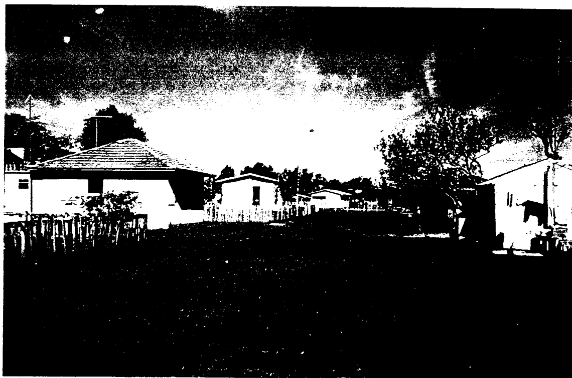
Foto 4 - Localidade de Capivaras - aspecto das casas.
