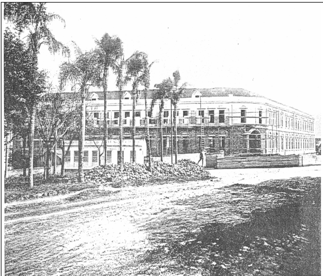
FIGURA 08 – Fachada do prédio em conclusão/1928 (Relatório da Cooperativa de Consumo dos Empregados da Viação Férrea do Rio Grande do Sul, 1929).
