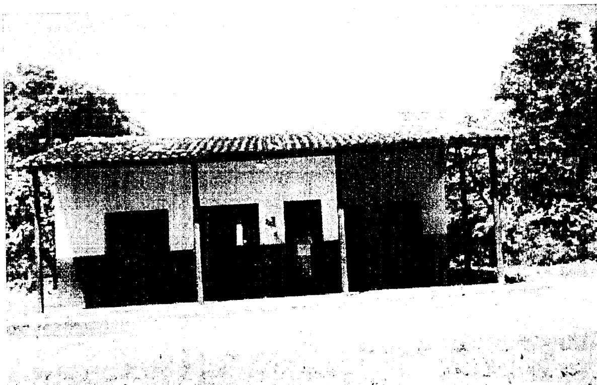
Figura 17 – Vista frontal da escola da comunidade. Fonte: BORDEST, R (2000).
