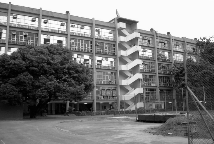
Visão do pátio interno nos fundos da escola
