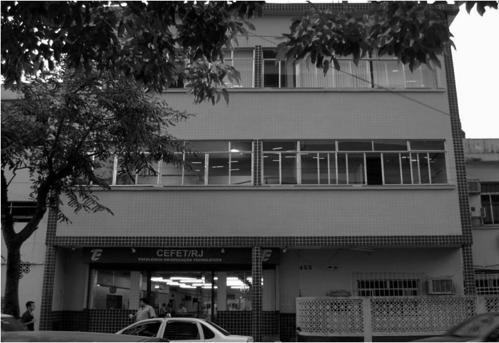
Vista da entrada principal
