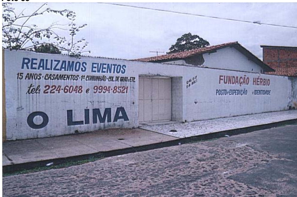
Parte externa da Creche “o Lima”. Fotografia: Antônio Nunes. Teresina, agosto, 2005.
