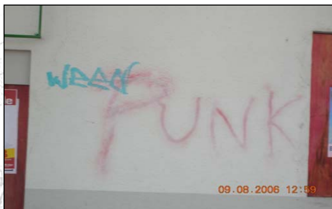
Figura 10: Parede externa de uma loja no Bom Fim.
